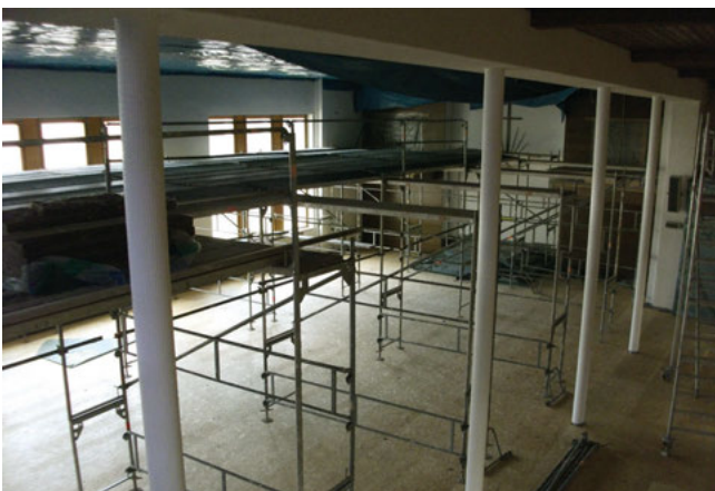
Im Kirchenschiff zu sehen die Gerüste für Maler- und Elektroarbeiten.
