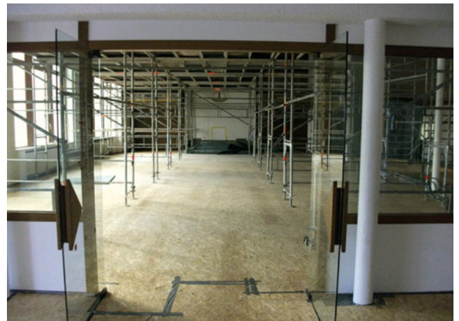
Weil der Fußboden bereits 2009 erneuert wurde, ist er mit Spanplatten geschützt, während das Kirchenschiff renoviert wird.
