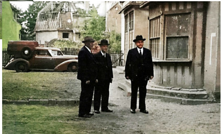
Beschädigte Nachbargebäude im Hintergrund.
