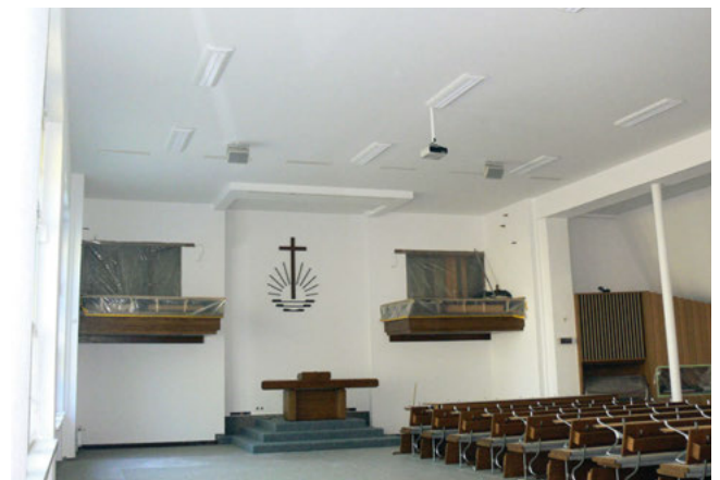
Zuletzt muss die Orgel wieder eingebaut werden.
