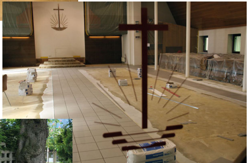
Der neue Boden im Entstehen.
