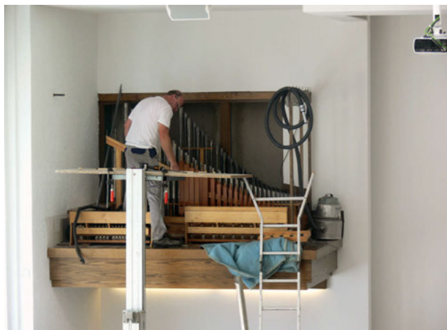
Sorgfältig werden beide Prospekte wieder bestückt, hier dasjenige links vom Altar.
