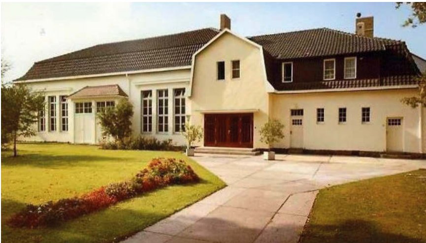
Nach einem Umbau befindet sich der Eingang zur Kirche nun an der Vorderseite des Gebäudes.
