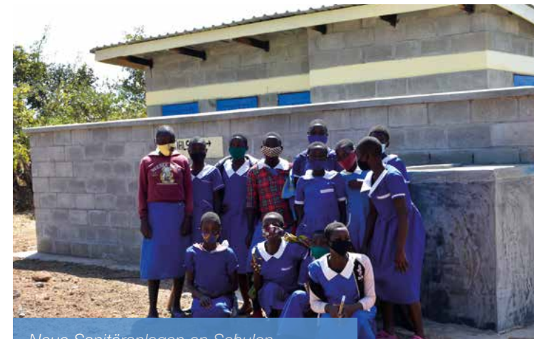
Neue Sanitäranlagen an Schulen...
